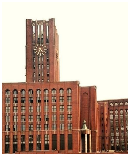
Ullstein-Haus mit dem 77 m hohen Turm am Tempelhofer Hafen. Erbaut 1925-1927 Foto: G. Küsel
